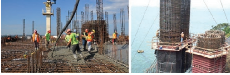
Kütle beton uygulama örnekleri
