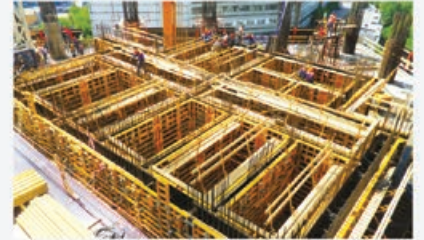
Asansör ve merdiven şaftı perdeleri
